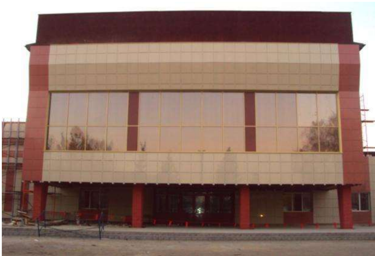
Рис.7. Идет реконструкция Районного дома культуры, октябрь 2011. Фото из архива автора.
